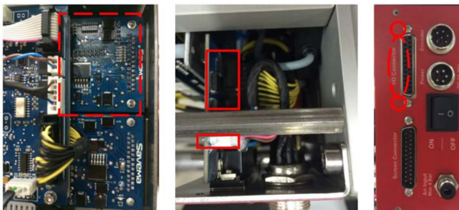
Рис. 47. Замена сигнальной платы
